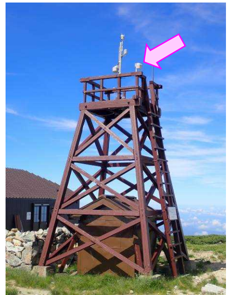
北アルプスの立山で水没した温度計の設置状況
