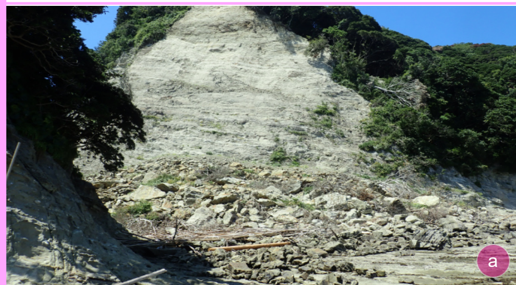
▲ 調査地の景観。調査地点から約 150m 離れた場所では、崖が崩落していました。
